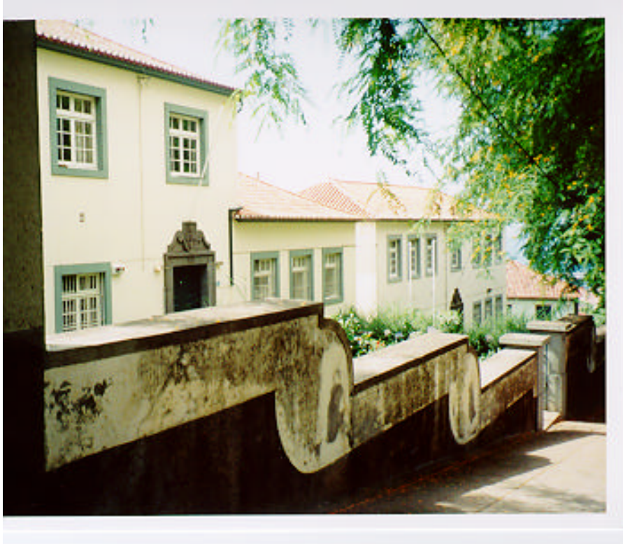
Foto 1 - Perspectiva dos dois edifícios do Plano dos Centenários que constituem actualmente a escola da Pena.
