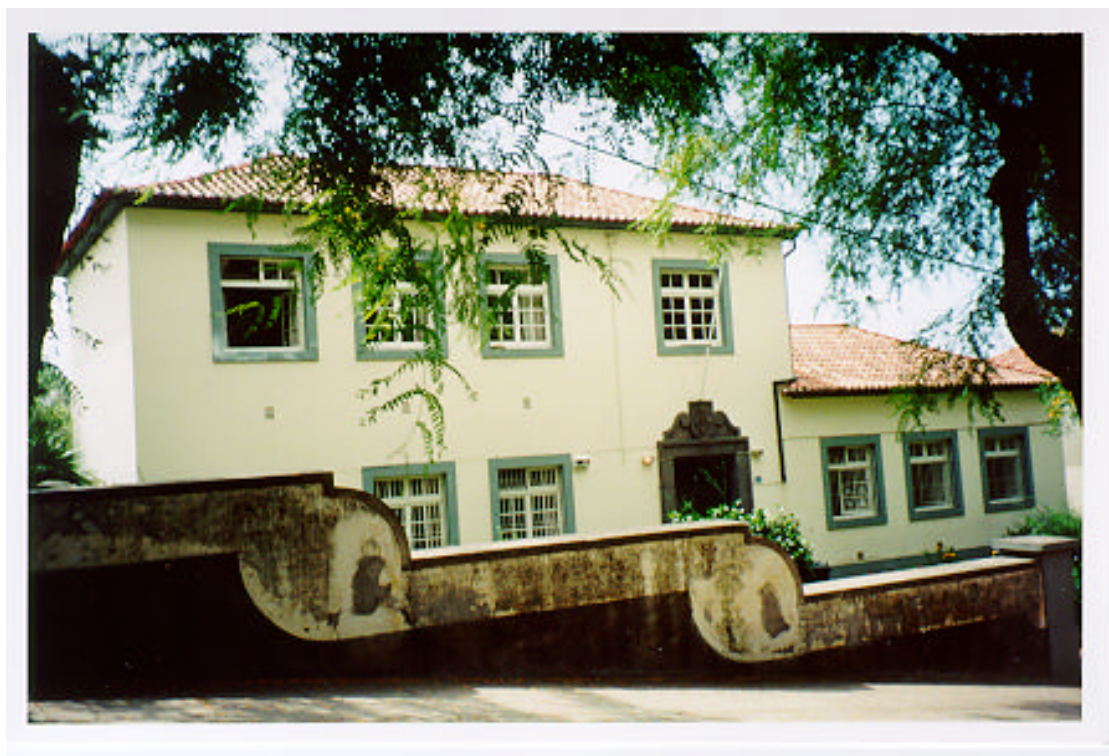
Foto 2 - Edifício da antiga escola nº 10.
