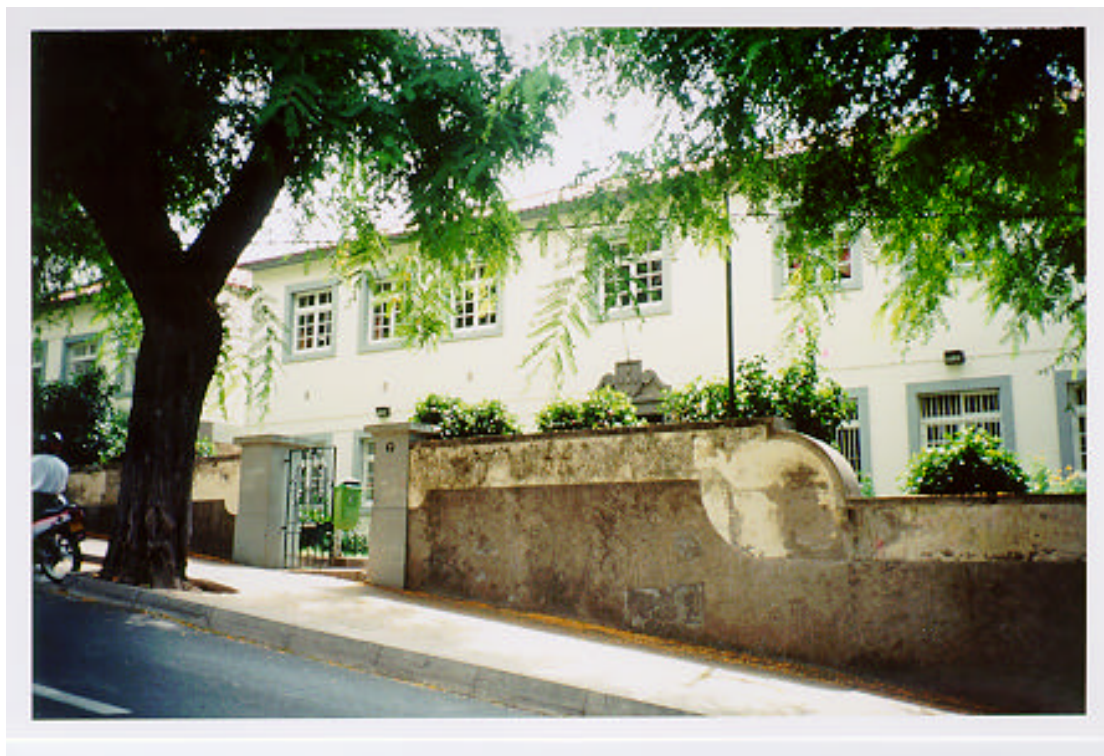
Foto 3 - Edifício da antiga escola nº 9
